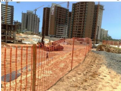
Figura 2: Modelo de isolamento com tapume tipo cerquite.
